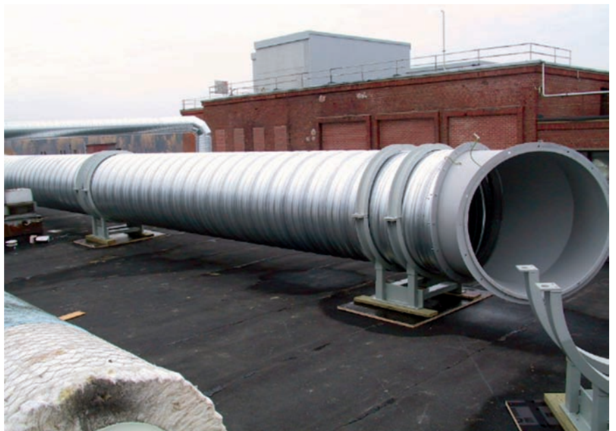
Rumtec-putket sallivat suuretkin jännevälit ripustetuissa putkilinjoissa. Putket voidaan tarvittaessa maalata.
